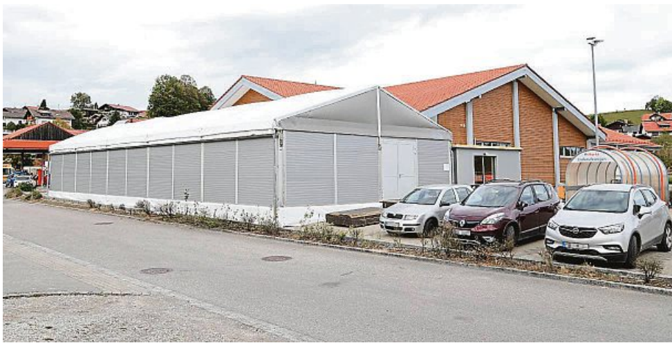
Eine fast 250 Quadratmeter große Leichtbauhalle ist auf dem V-Markt-Areal bereits entstanden. Sie verschwindet nach Abschluss des Umbaus wieder.
